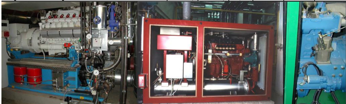
Abbildung 4: Einbau von Kraft-Wärme-Kopplungs-Anlagen
