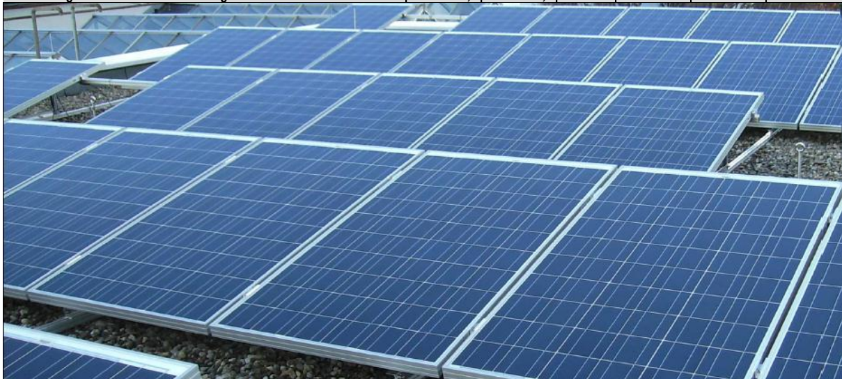
Abbildung 3: Einbau von Photovoltaikanlagen
